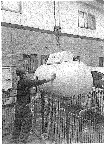
クレーンで吊り上げて交換工事を行う
