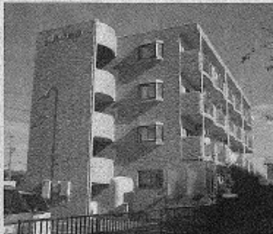
まずモデルとして自社物件に発電機を導入する
