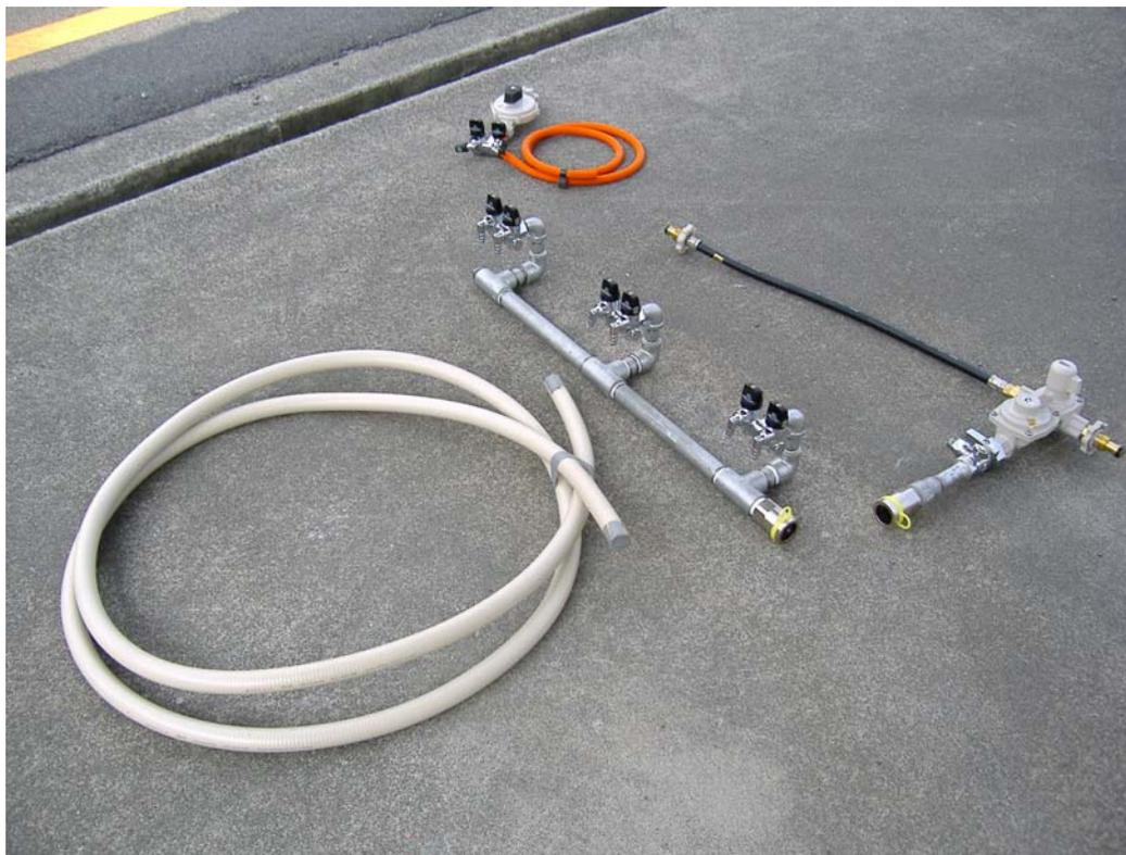
20Aフレキ管、2口ヒューズガス栓、簡易自動切替(8kg/h)、5kg/h単段調整器、ゴムホース、ホースバンド・ゴムキャップ、15A・20A 継手類(L, T, N等)を準備しています。
