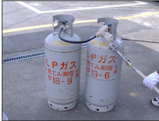
① 簡易自動切替(8kg/h) に異径S(ソケット)1/2×3/4 とフレキ用ワンタッチ継手20A を付ける
