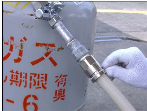
④ ナットとリングを確実に押し込む
